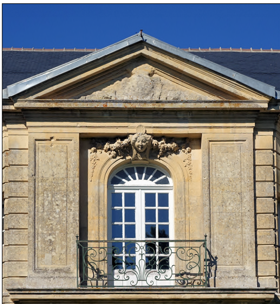
Fig. 1.2. Etage de l'avant-corps (façade sud-ouest)
