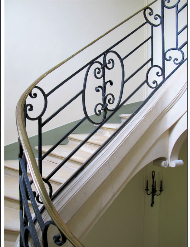
Fig. E.4. Escalier
