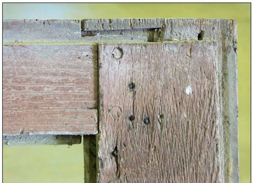
Fig. 1.6. Volet inf. droit (assemblage modifié)
