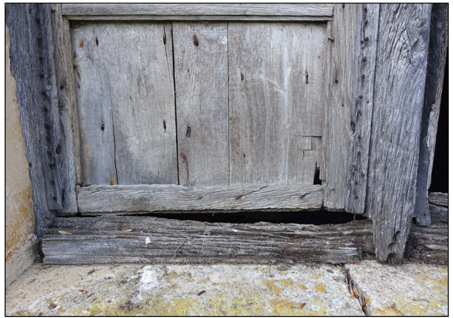
Fig. 7.4. Châssis C (pièce d'appui et meneau)
