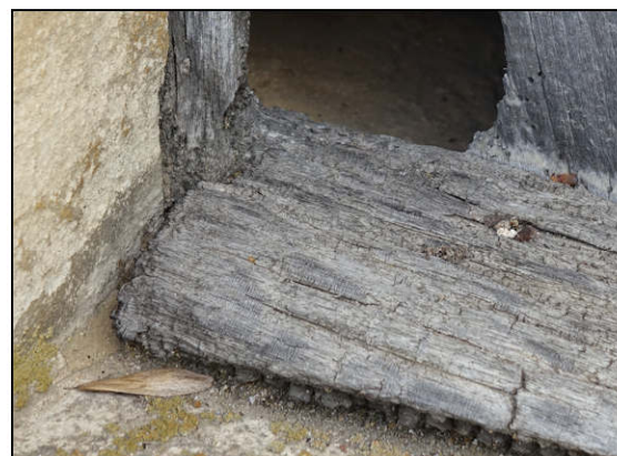
Fig. 7.6. Châssis D (pièce d'appui)
