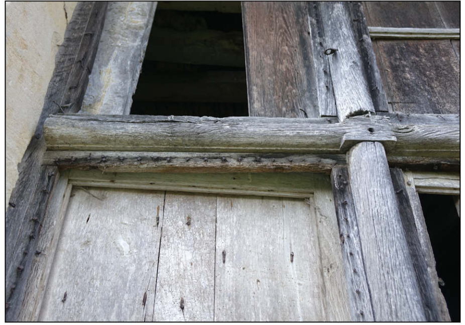
Fig. 7.2. Châssis C (meneau et croisillon)
