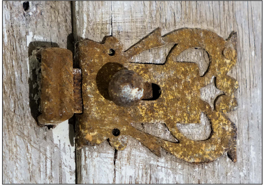
Fig. 3.2. Targette encoisonnée (volet supérieur)
