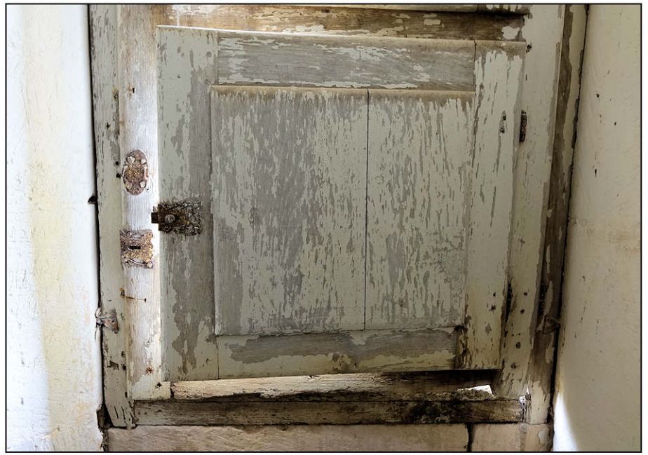
Fig. 3.4. Vantail vitré et volet inférieur (vue intérieure)
