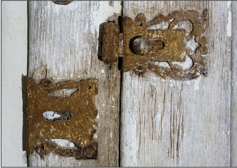
Fig. 3.1. Targettes encoisonnées (vantail et volet inférieur)
