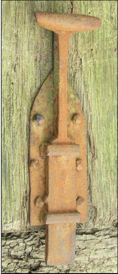
Fig. 2.3. Verrou inférieur
