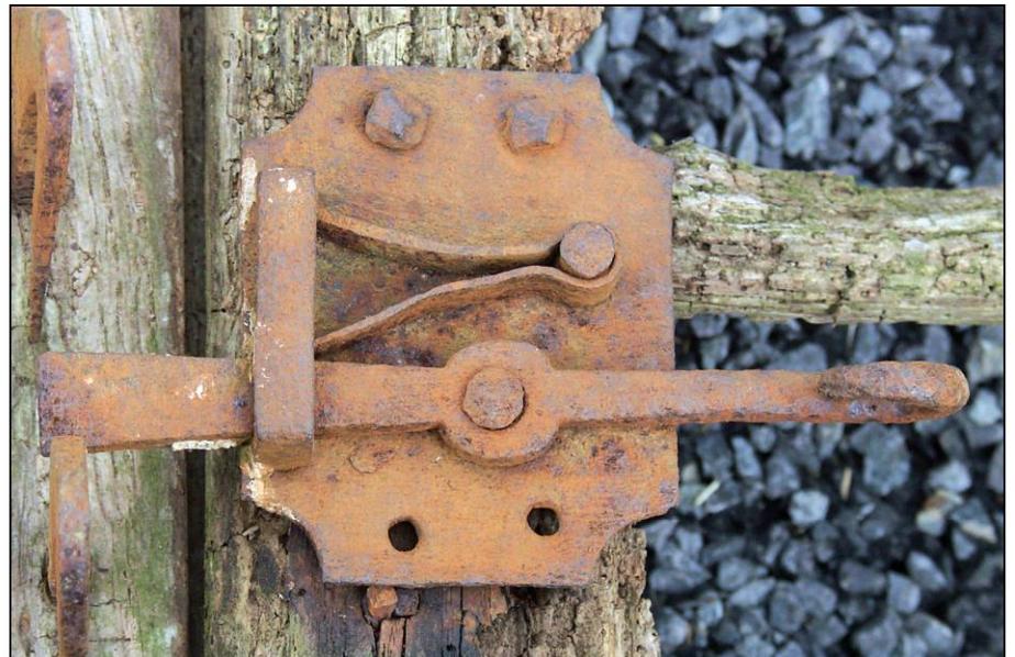
Fig. 2.7. Targette (vantail vitré droit)
