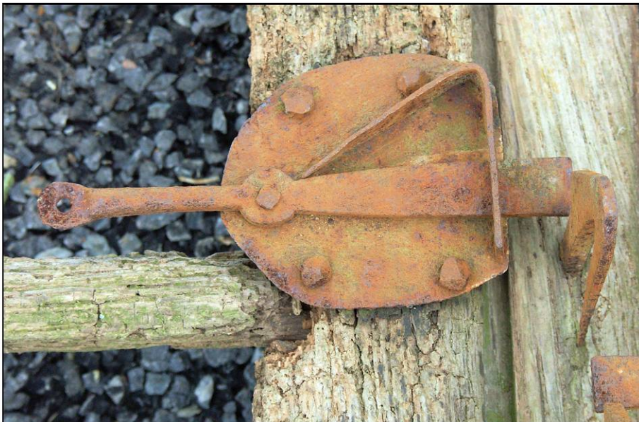
Fig. 2.6. Targette (vantail vitré gauche)
