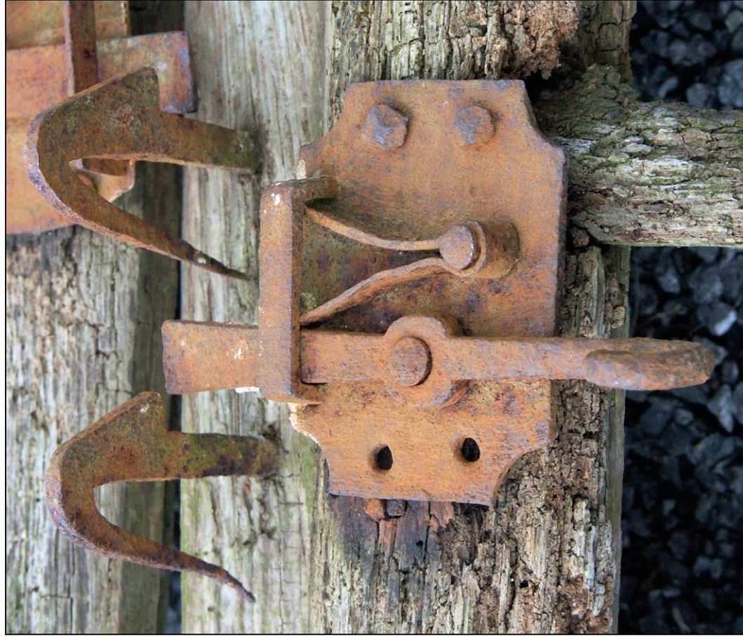
Fig. 2.2. Targette (vantail vitré droit)
