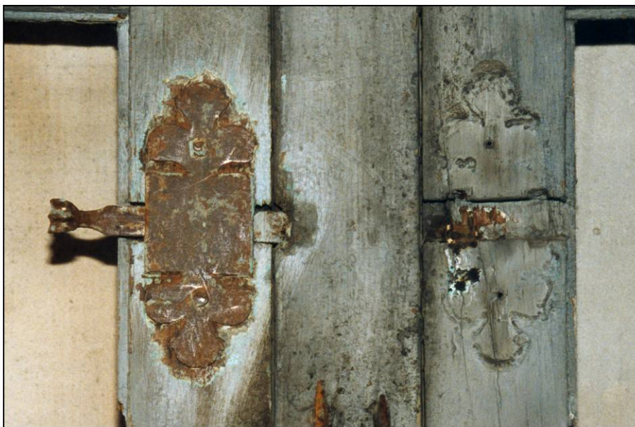
Fig. 3.3. Targette enclouonnée
