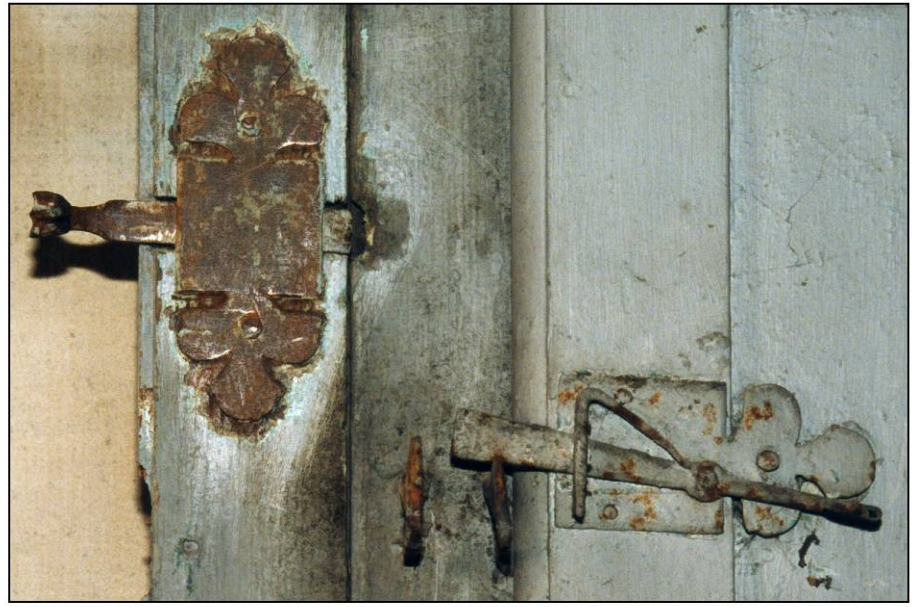
Fig. 3.2. Targette enclouonnée (vantail vitré) et loquet à ressort (volet)
