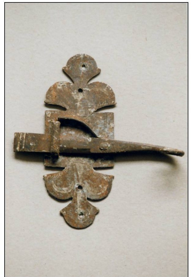
Fig. 3.4. Loquet à ressort (autre croisée)
