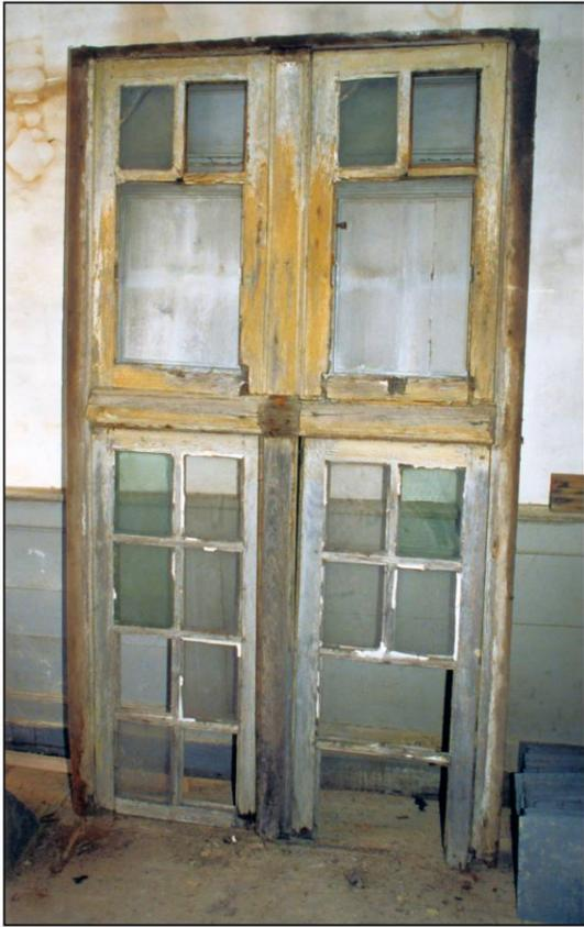
Fig. 2.1. Croisée / élévation extérieure
