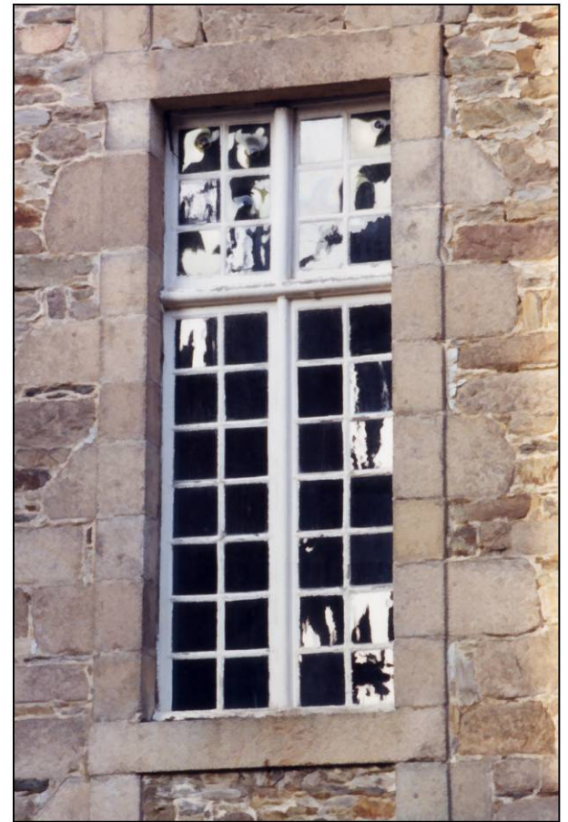
Fig. 1.4. Façade sud / pavillon ouest
