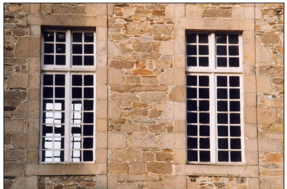
Fig. 1.6. Façade sud / pavillon ouest
