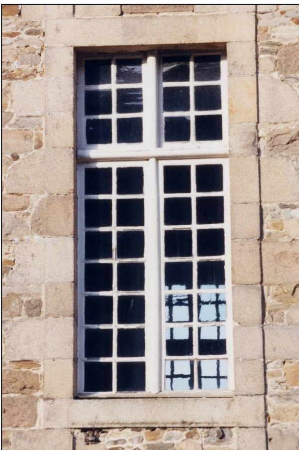
Fig. 1.5. Façade sud / pavillon ouest
