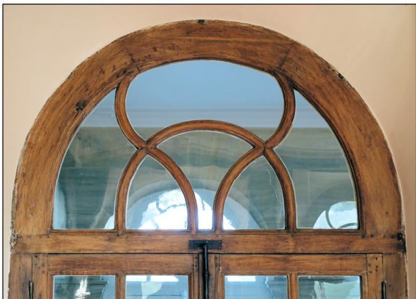
Fig. 3.3. Imposte (élévation intérieure)
