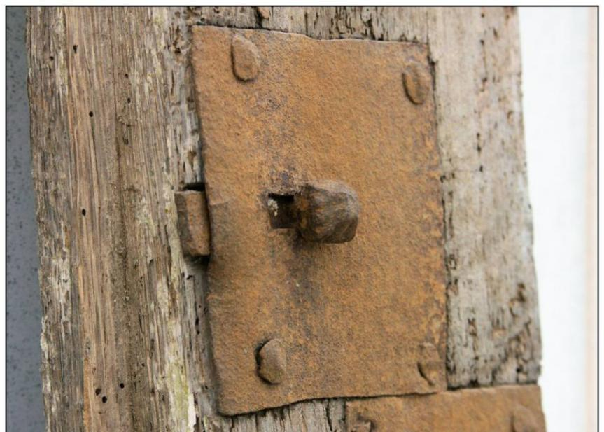
Fig. 3.6. Targette enclouonnée (bâti dormant)
