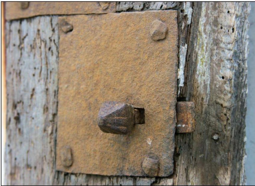
Fig. 3.3. Targette enclouonnée (bâti dormant)
