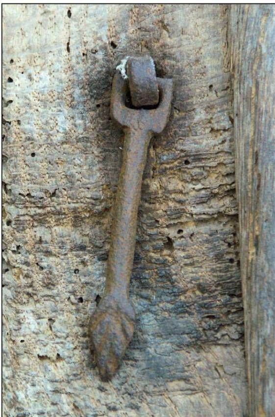
Fig. 3.5. Pendeloque (vantail vitré droit)
