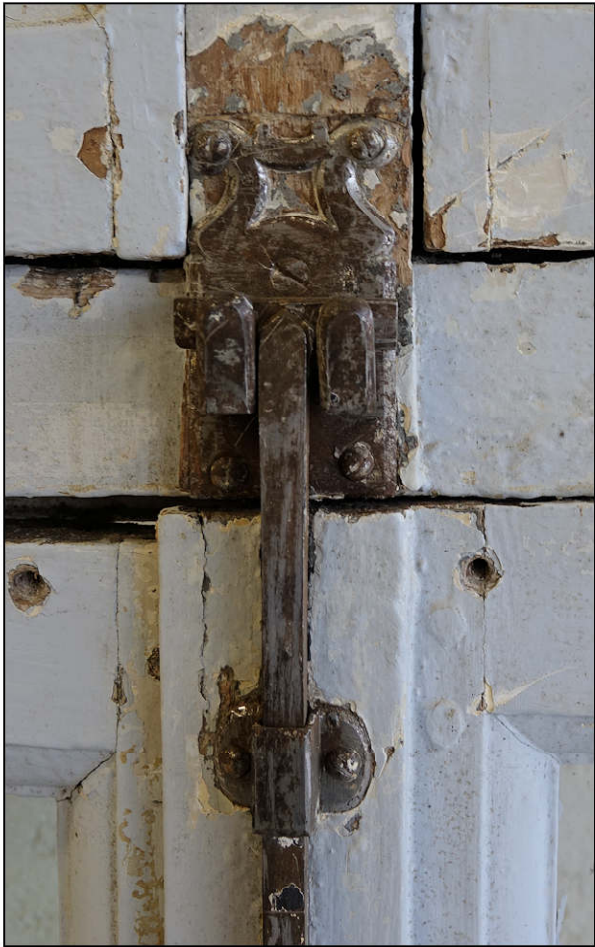
Fig. 3.1. Gâche / pêne en T / conduit
