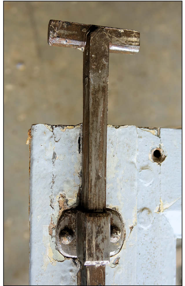
Fig. 3.3. Pêne en T et conduit
