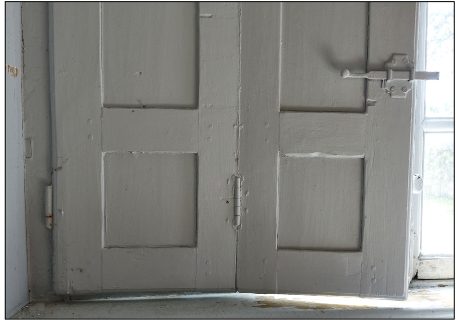
Fig. 3.2. Volet brisé (élévation intérieure)
