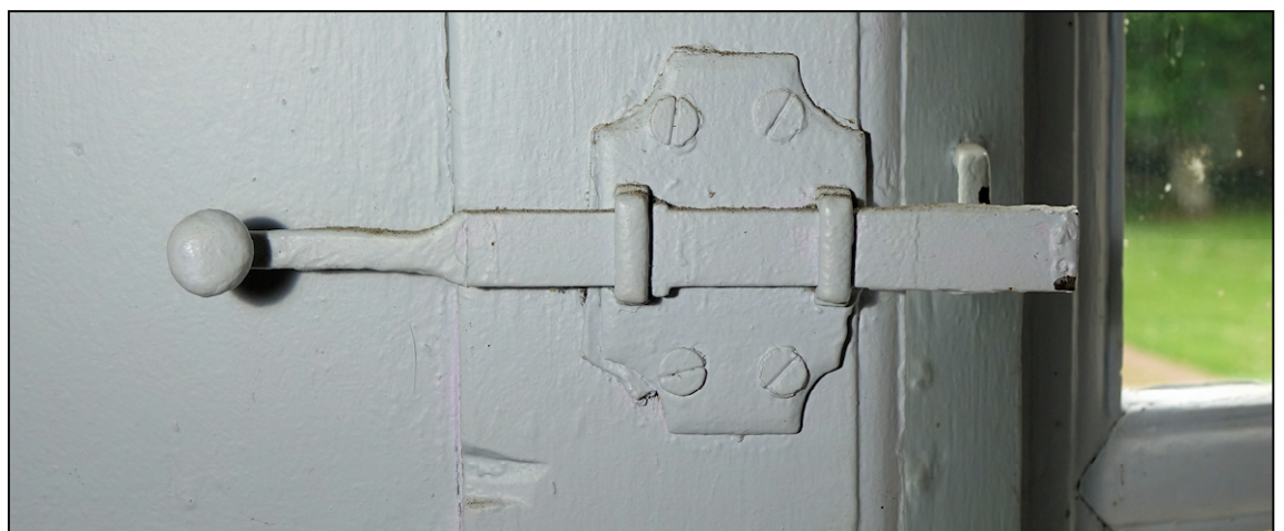
Fig. 3.5. et 3.6. Loquet et targette
