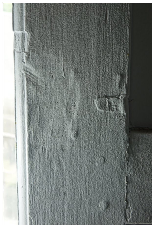
Fig. E.6. Montant gauche du volet droit. A noter la dépression sur le bois indiquant l'emplacement de l'ancienne targette et l'entaille rebouchée au droit de l'emplacement de son pêne
