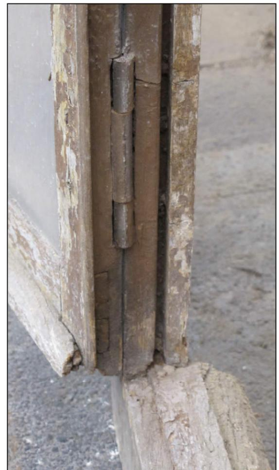
Fig. 4.5. Pièce d'appui et jet d'eau (B)
