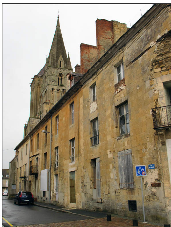
Fig. 2.3. Aile ouest (façade ouest)
