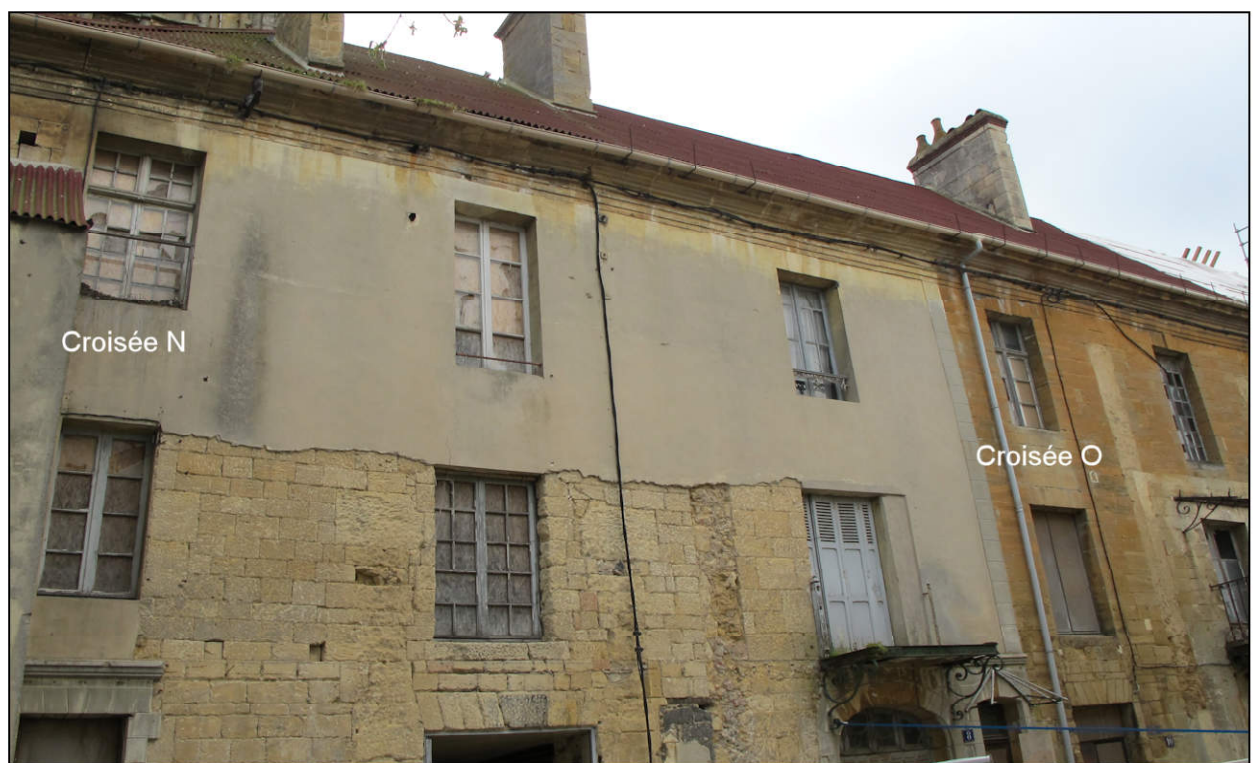
Fig. 2.4. Aile ouest (façade ouest)
