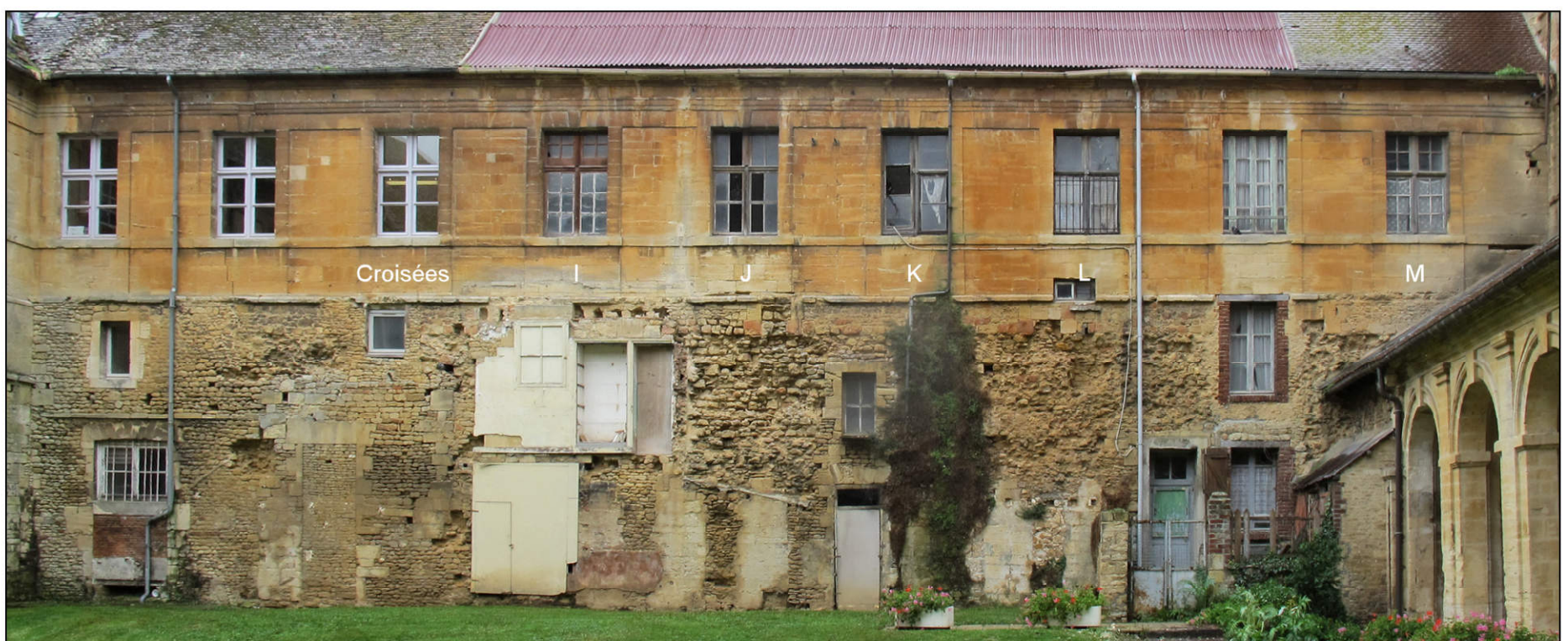
Fig. 2.2. Aile ouest (façade est sur le cloître)
