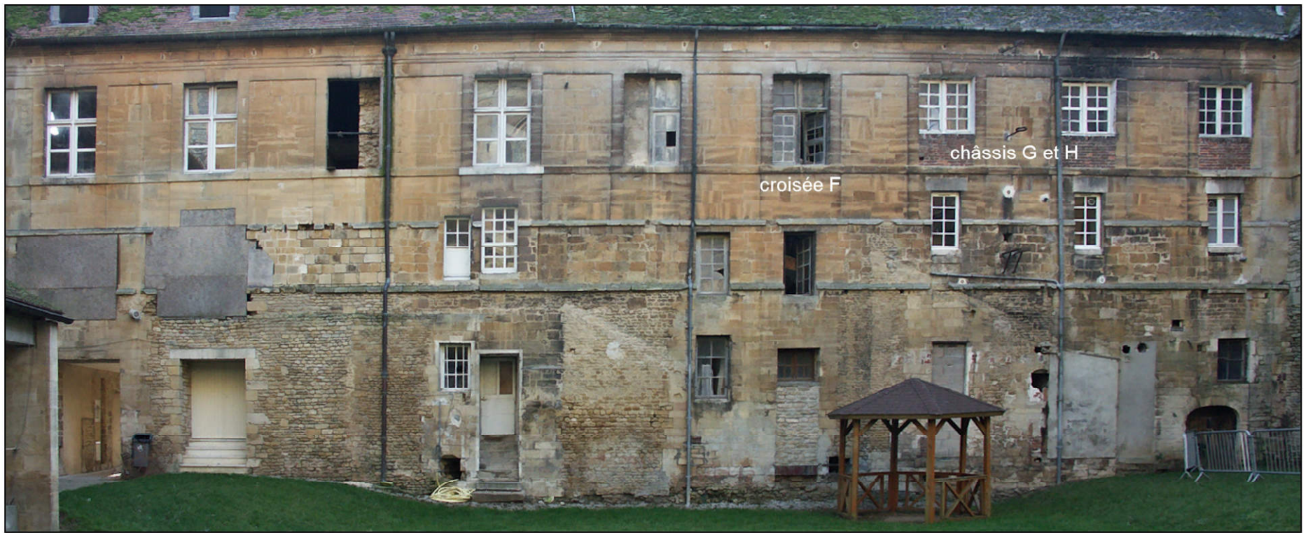
Fig. 2.1. Aile sud (façade nord sur le cloître)
