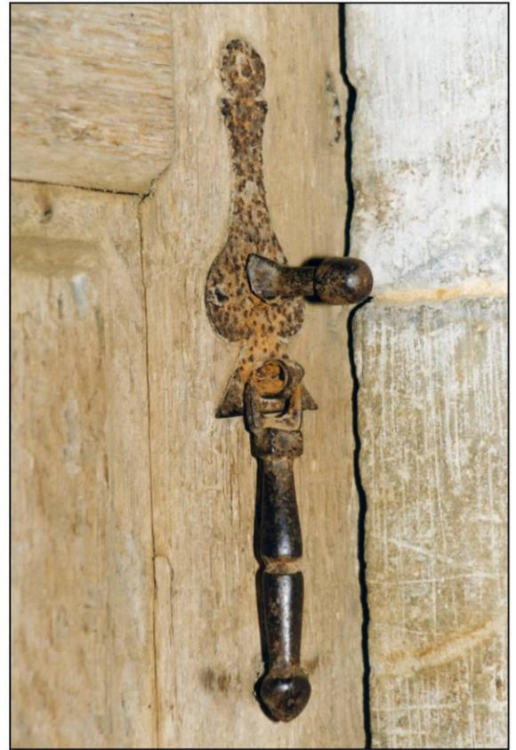
Fig. 5.3. Vantail D / Loquet à poucier
