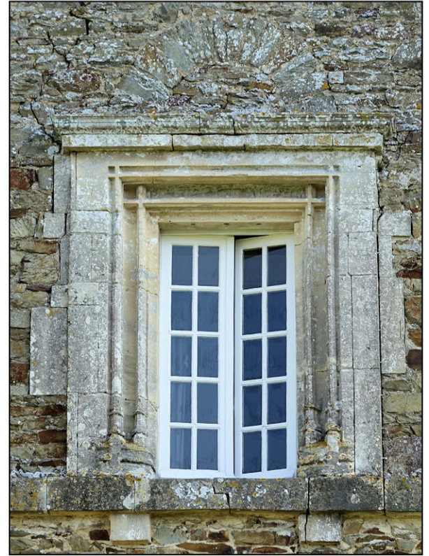
Fig. 1.2. Fenêtre du 1er étage
