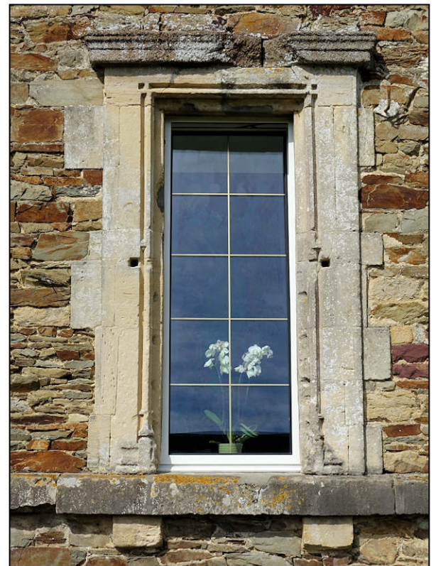
Fig. 1.4. Fenêtre du rez-de-chaussée
