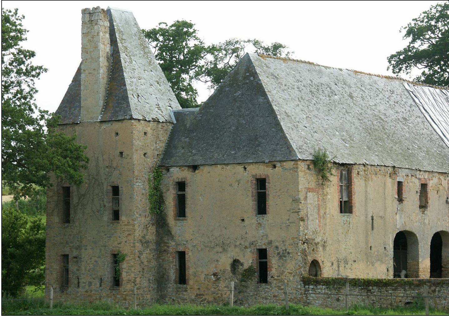
Fig. 1.1. Façades nord-est et nord-ouest
