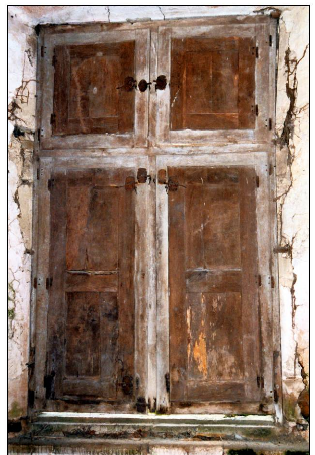
Fig. 1.5. Croisée (élévation intérieure)
