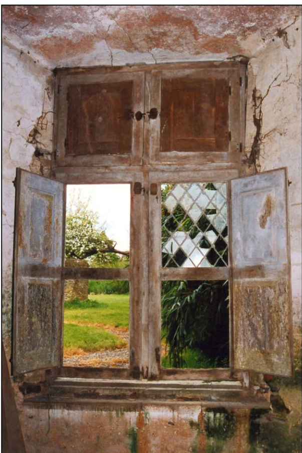
Fig. 1.3. Croisée (élévation intérieure)
