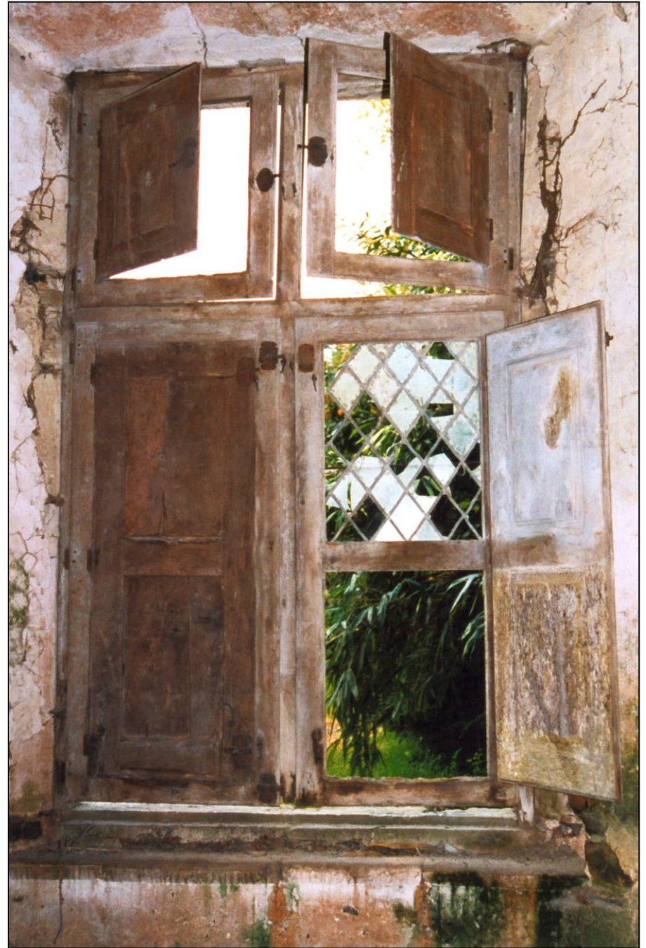
Fig. 1.2. Croisée (élévation intérieure)
