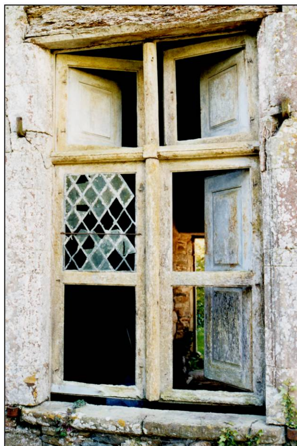
Fig. 1.4. Croisée (élévation extérieure)
