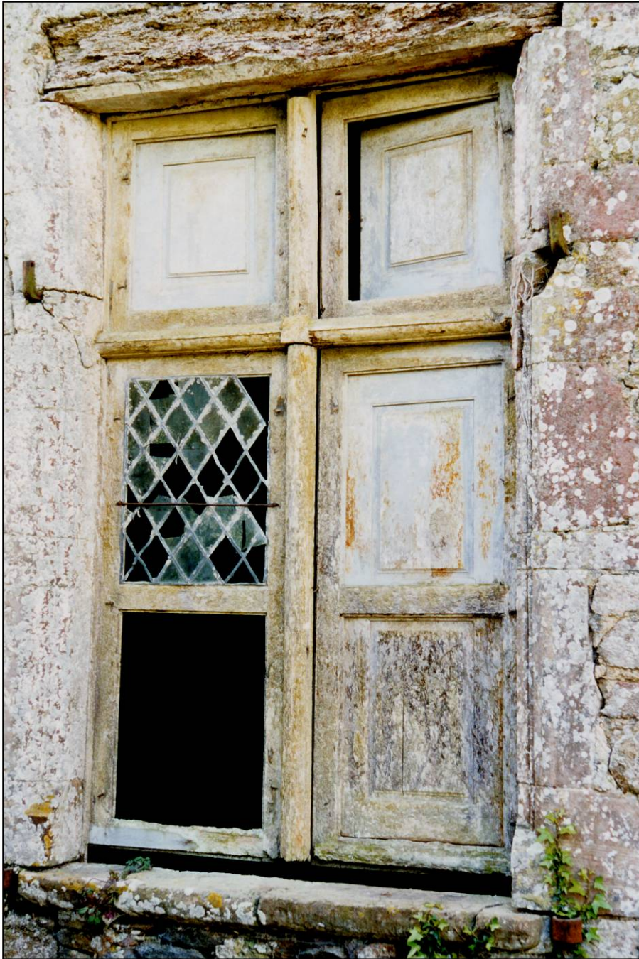
Fig. 1.1. Croisée (élévation extérieure)
