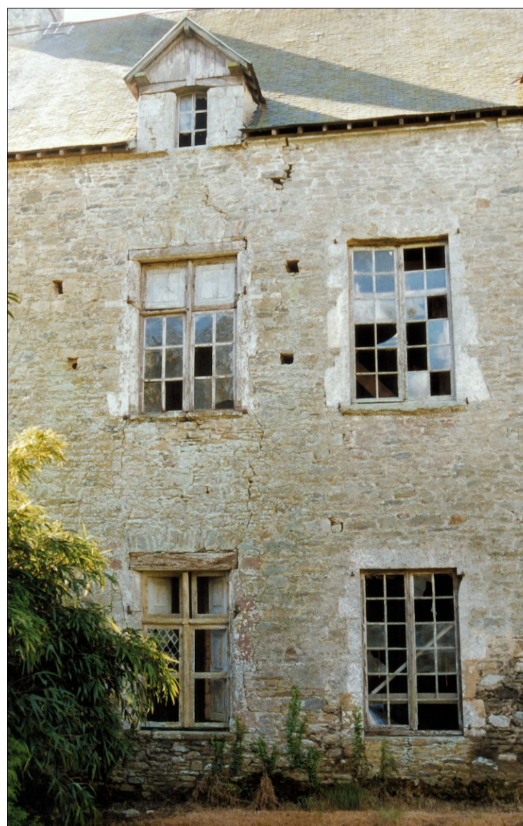
Fig. E.1. La croisée au rez-de-chaussée
