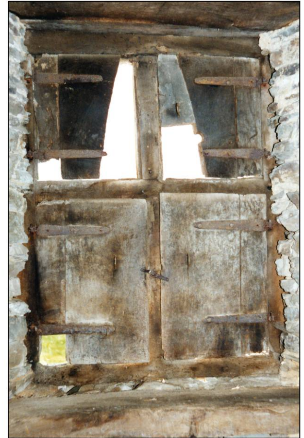
Fig. 2.2. Croisée (élévation intérieure)
