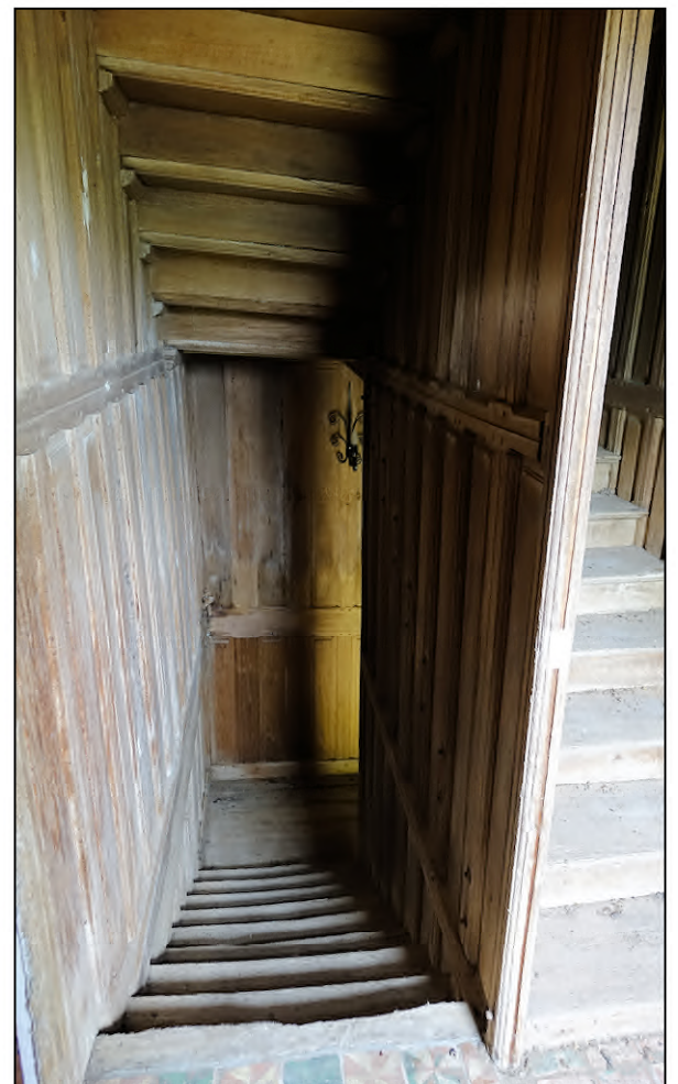
Fig. 2.6. Volée d'escalier menant à l'étage
