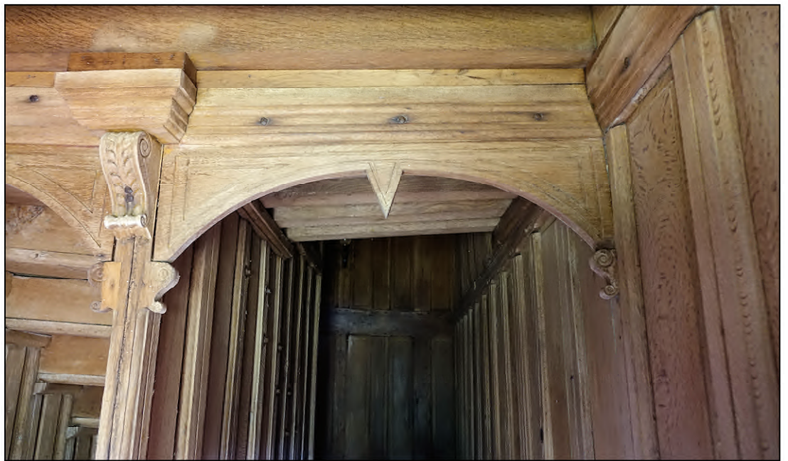
Fig. 2.3. Détail de l'escalier à l'étage
