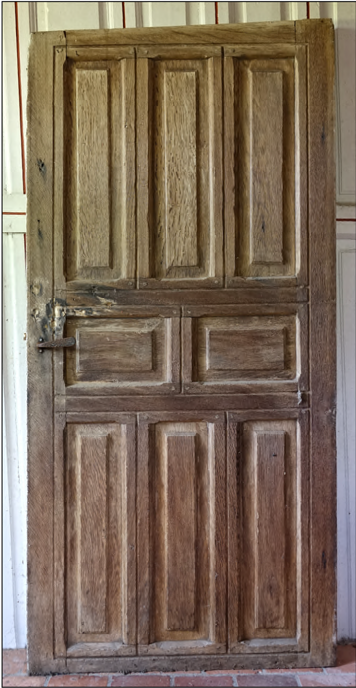
Fig. 2.1. Porte de l'étage (petite chambre)
