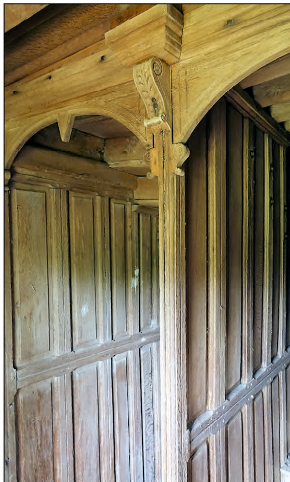
Fig. 2.5. Détail de l'escalier à l'étage
