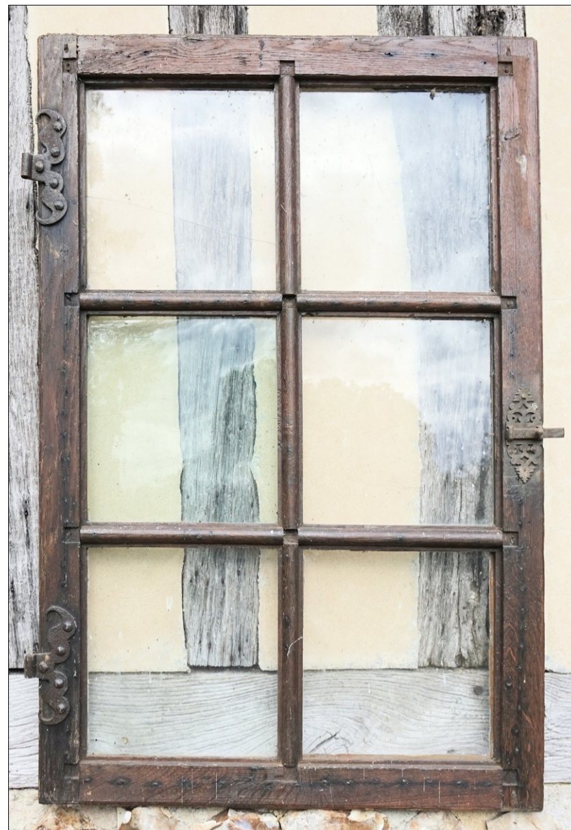
Fig. E.3. Le châssis (vue intérieure)
