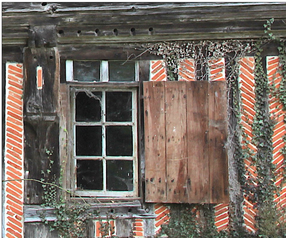
Fig. E.2. Le châssis du rez-de-chaussée Photo Yves Lescroart (détail)
