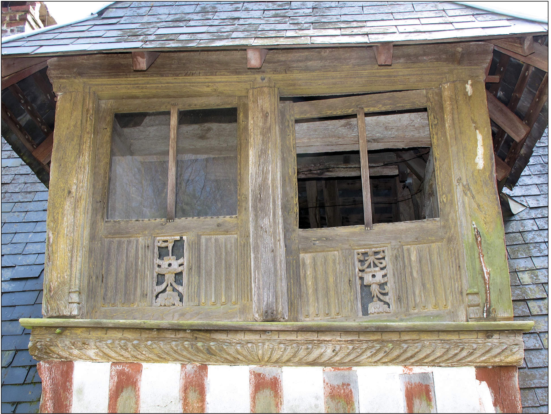
Fig. 1.1. Lucarne (façade nord-ouest)
