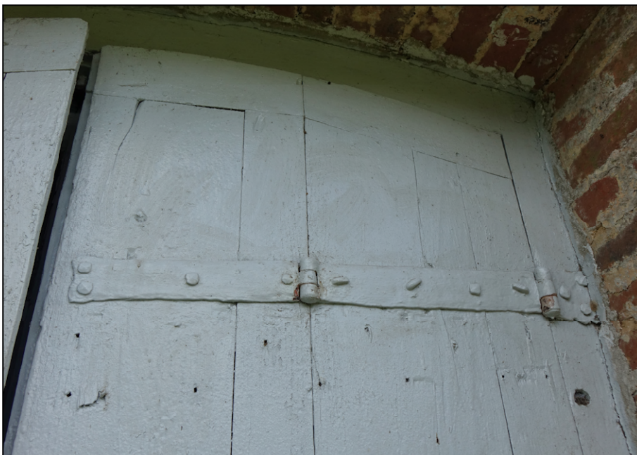
Fig. 4.6. Ferrure d'un contrevent
