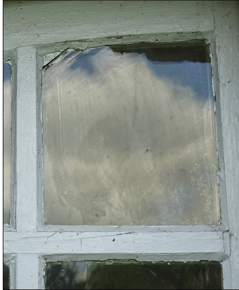
Fig. 4.2. Carreau avec un bourrelet périphérique
