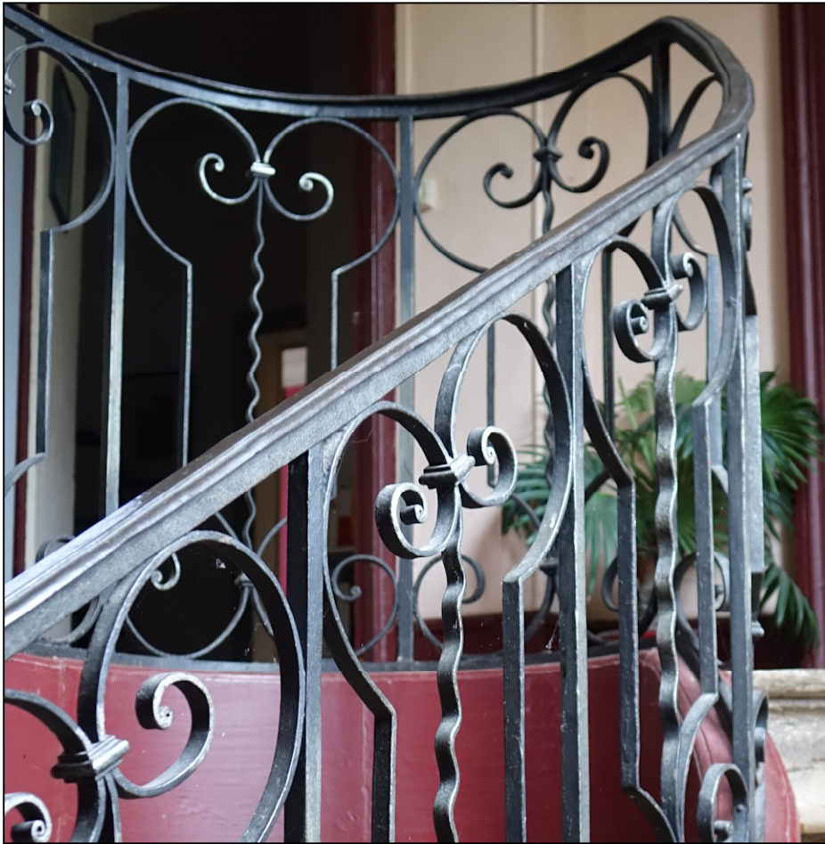
Fig. 2.1. Garde-corps de l'escalier
