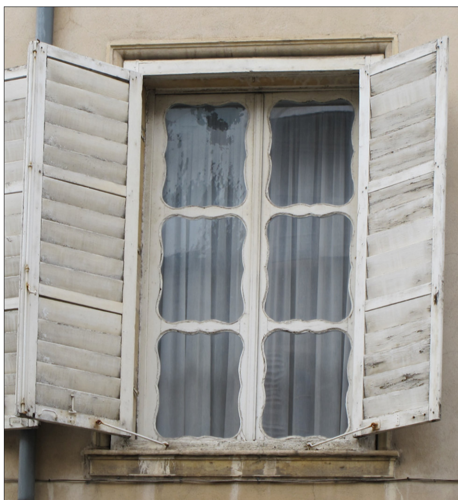
Fig. E.3. Nancy, immeuble, 30 rue des Tiercelins. Fig. E.4. Nancy, Immeuble, 8 rue du Haut-Bourgeois. Source A. Tiercelin
