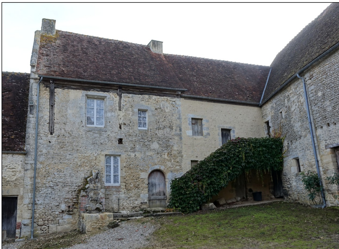
Fig E.2. Vue de l'angle sud-est depuis la cour. A gauche, puis à droite en retour, les deux logis du XV e siècle, le second étant le plus ancien (le tuyau de descente de la gouttière dissimule sa chaîne d'angle). En prolongement du premier, le bâtiment de liaison entre les deux logis (mur restauré).
