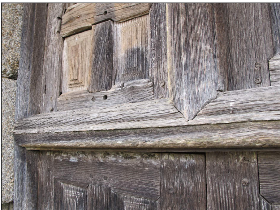
Fig. 2.7. Meneau / croisillon (assemblage)
