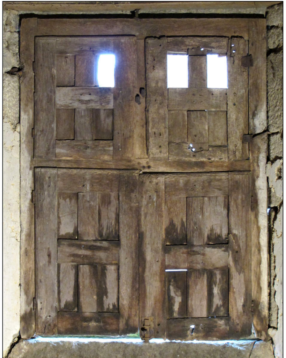
Fig. 1.2. Croisée / élévation intérieure
