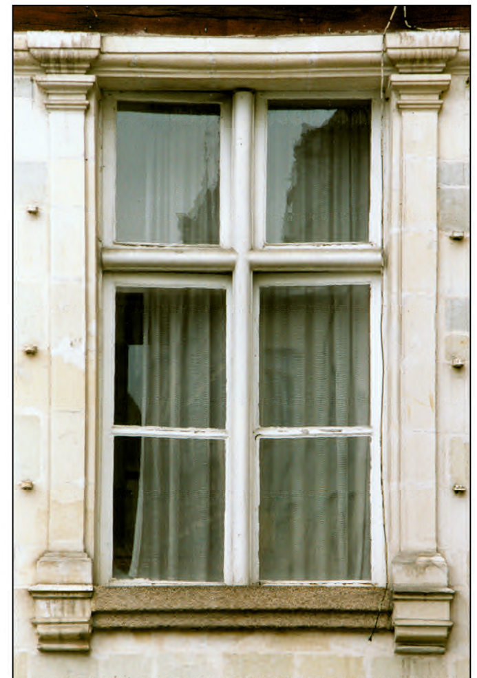
Fig. 1.5. Croisée du rez-de-chaussée (2000)
