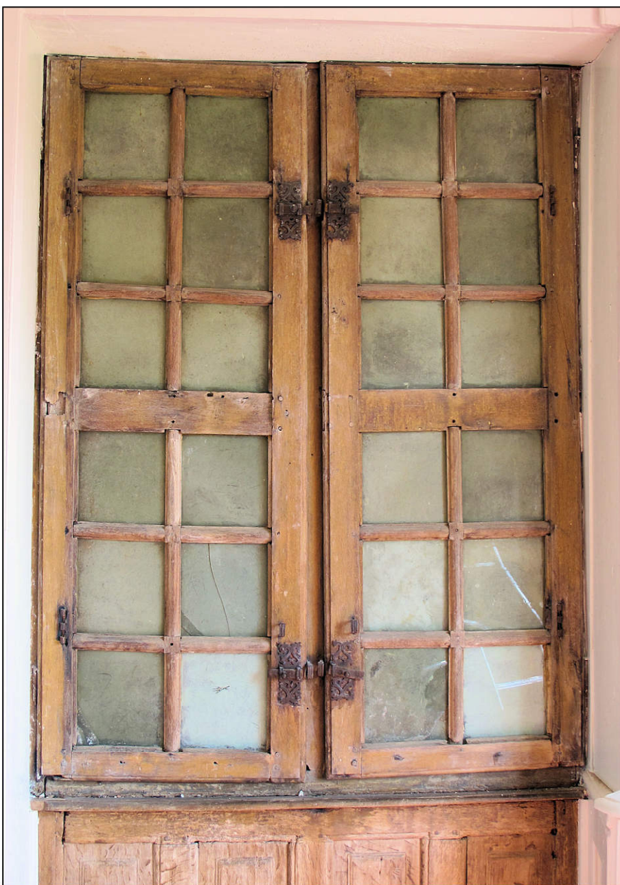
Fig. 1.2. Châssis (volets déposés)
