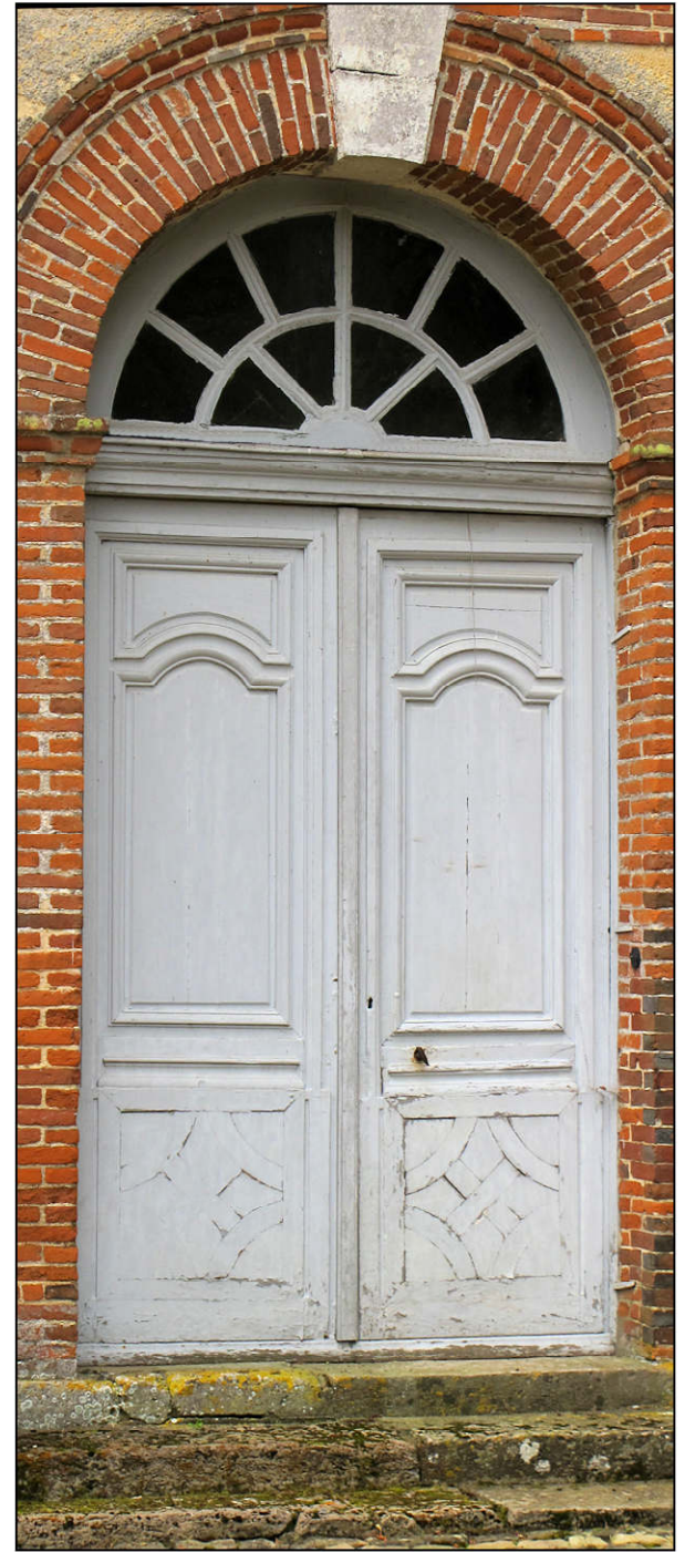
Fig. 1.3. Porte (façade nord)
