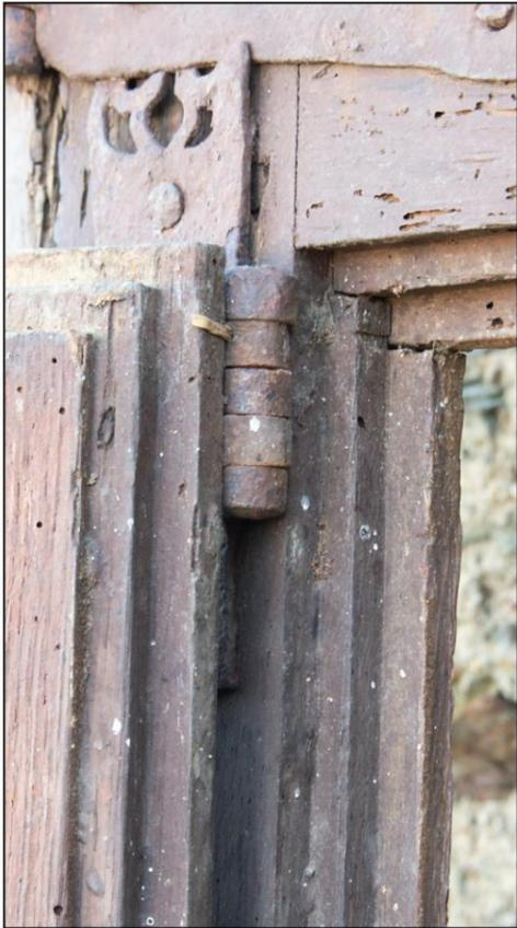
Fig. 4.1. Dormant / vantail (double feuillure)
