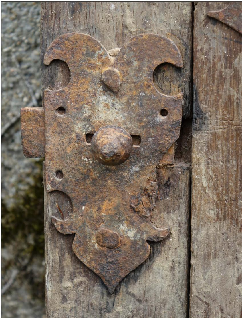
Fig. 4.3. Targette enclouonnée (vantaill vitré)
