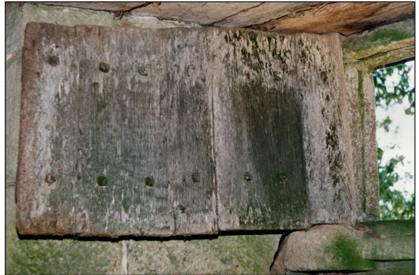
Fig. 4.5. Volet sup. (élévation extérieure)
