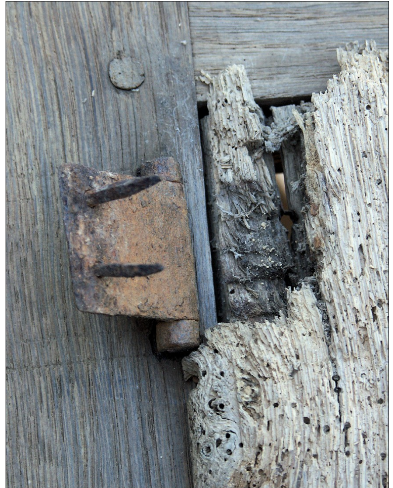
Fig. E.2. Fiche à broche rivée et mortaise
