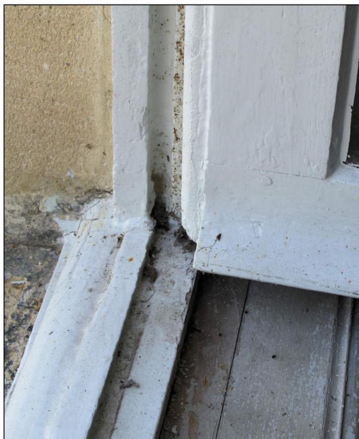
Fig. 3.3. Pièce d'appui et jet d'eau
