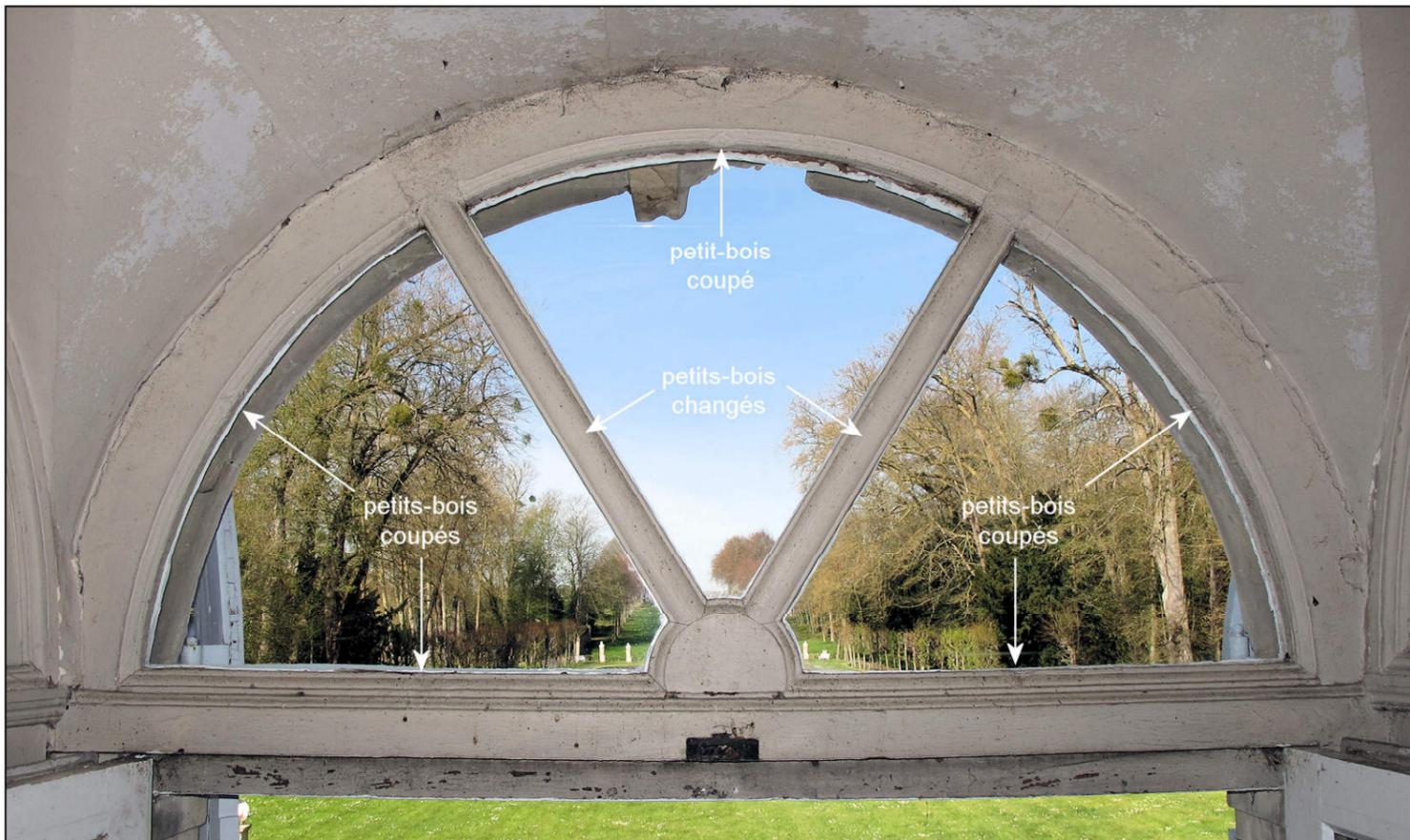
Fig. 3.1. Châssis d'imposte en éventail
