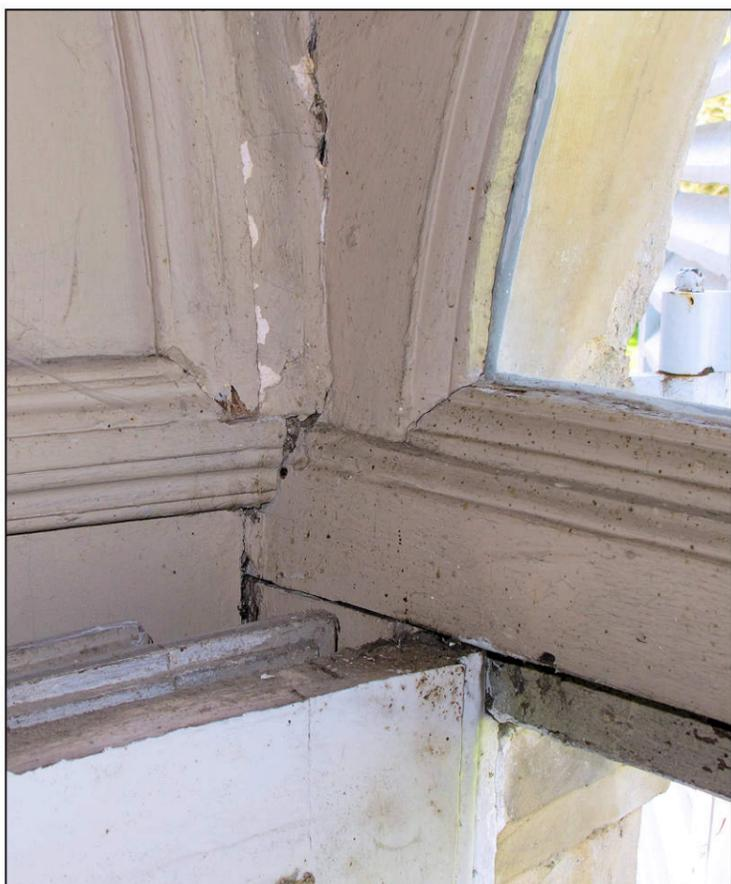
Fig. 3.2. Assemblage de la traverse d'imposte
