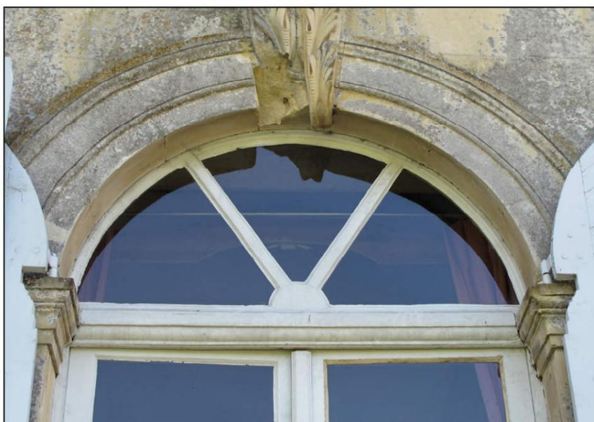
Fig. 3.4. Châssis d'imposte
