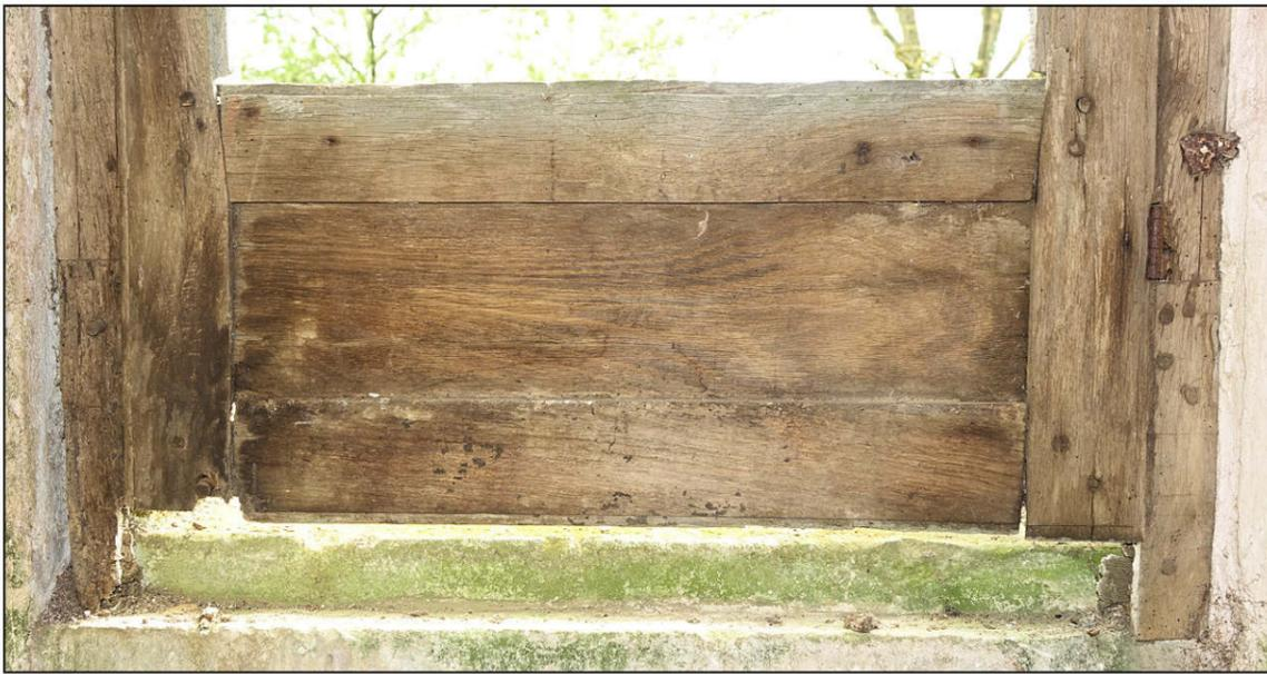
Fig. 2.2 Soubassement (élévation intérieure)
