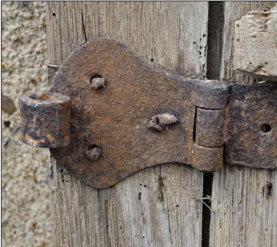
Fig. 2.1. Penture à charnière supérieure
