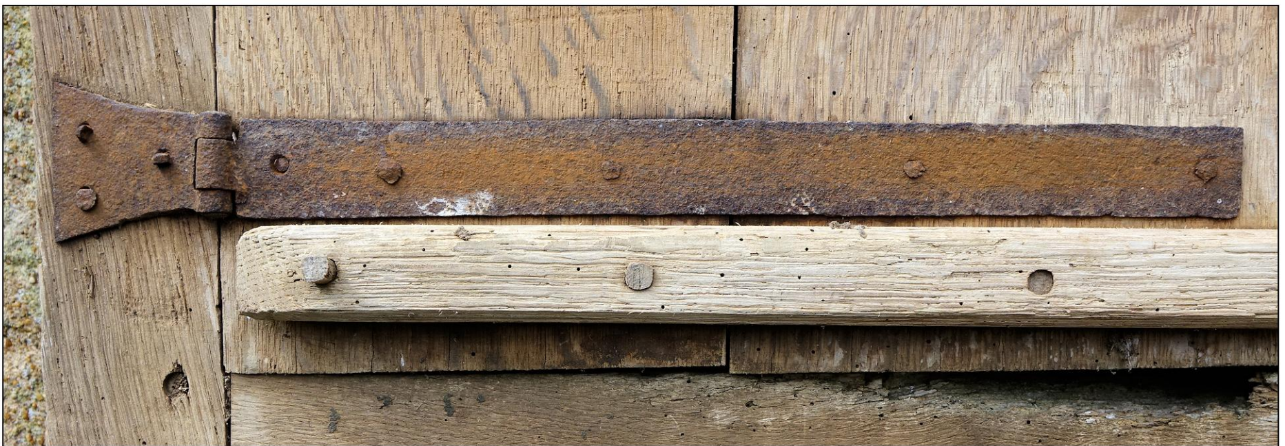
Fig. 2.3. Penture à charnière inférieure
