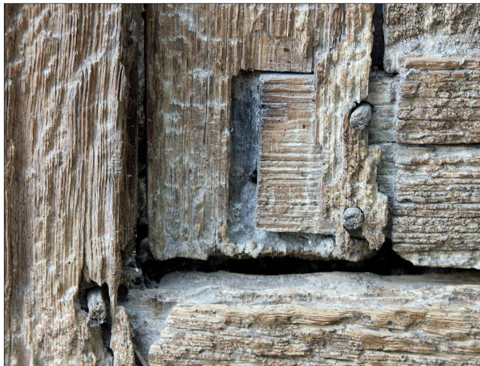
Fig. E.1. Assemblage à tenon et mortaise du volet
