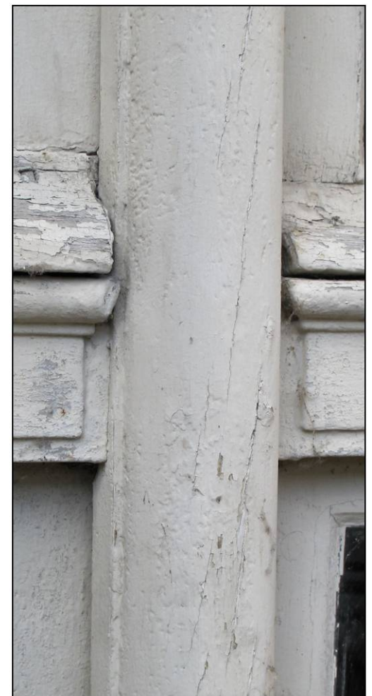
Fig. 4.4. Assemblage meneau / croisillon
