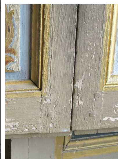
Château de Vaux-le-Vicomte Fig. E.5 (à gauche) Croisée RdC 2 – Volet du XVIIe siècle. Les chevilles sont parallèles aux araselements. Fig. E.6 (au centre) Croisée RdC 4 – Volet refait Fig. E.7 (ci-dessous) Croisée RdC 4 – Volet refait (détail). Les chevilles sont décalées.
