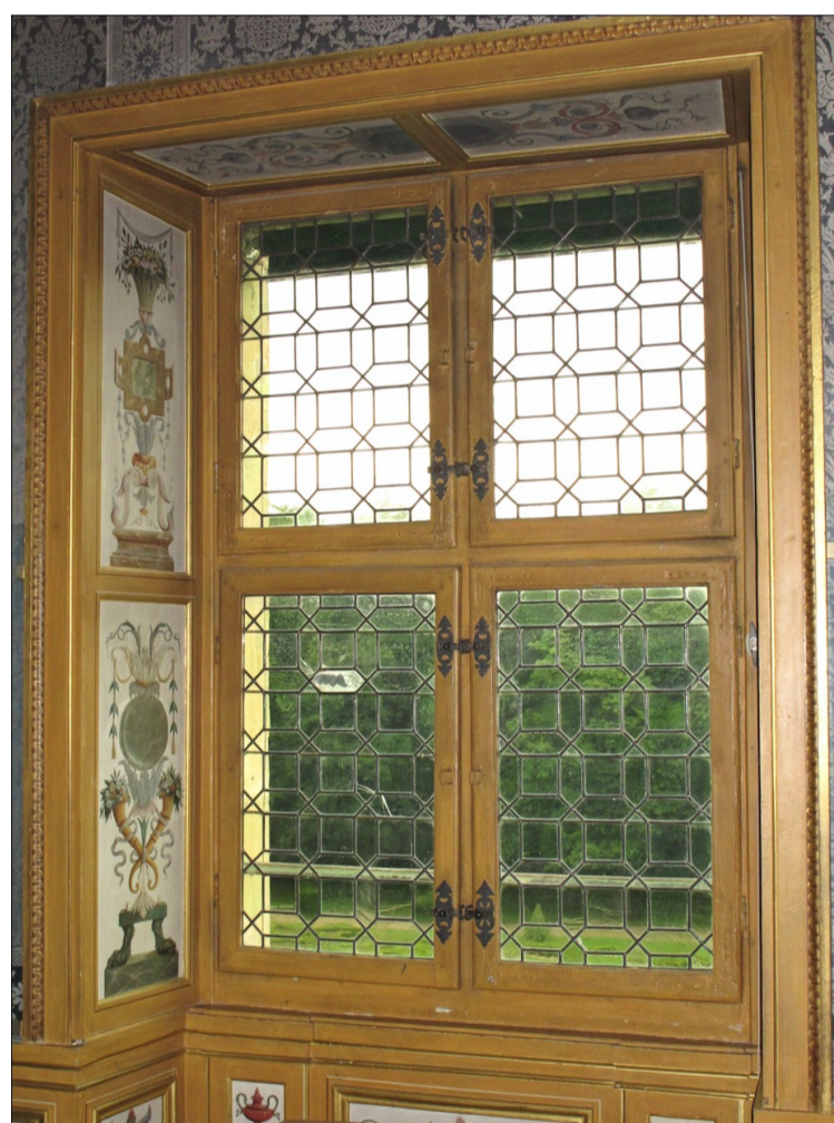
Fig. E.9. Château de Vaux-le-Vicomte Croisée E 57 Vitreries restituées (bornes en carré)
