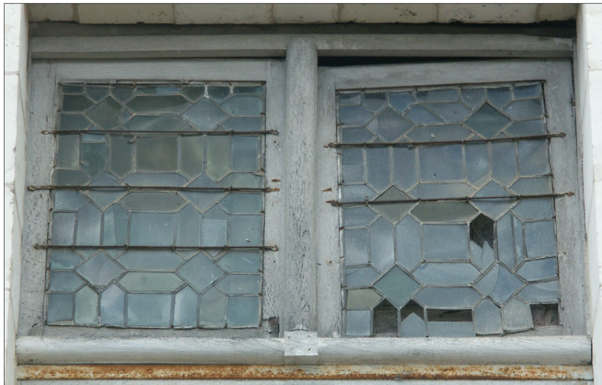
Fig. E.10 - Richelieu (Indre-et-Loire) Hôtel de la Grande Rue (vers 1635) Vitrerie dissymétrique sur ses deux axes.
