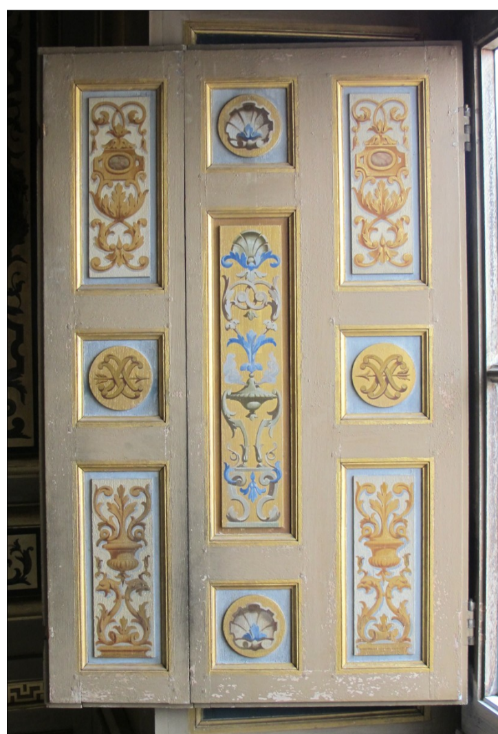
Château de Vaux-le-Vicomte Fig. E.5 (à gauche) Croisée RdC 2 – Volet du XVIIe siècle. Les chevilles sont parallèles aux araselements. Fig. E.6 (au centre) Croisée RdC 4 – Volet refait Fig. E.7 (ci-dessous) Croisée RdC 4 – Volet refait (détail). Les chevilles sont décalées.
