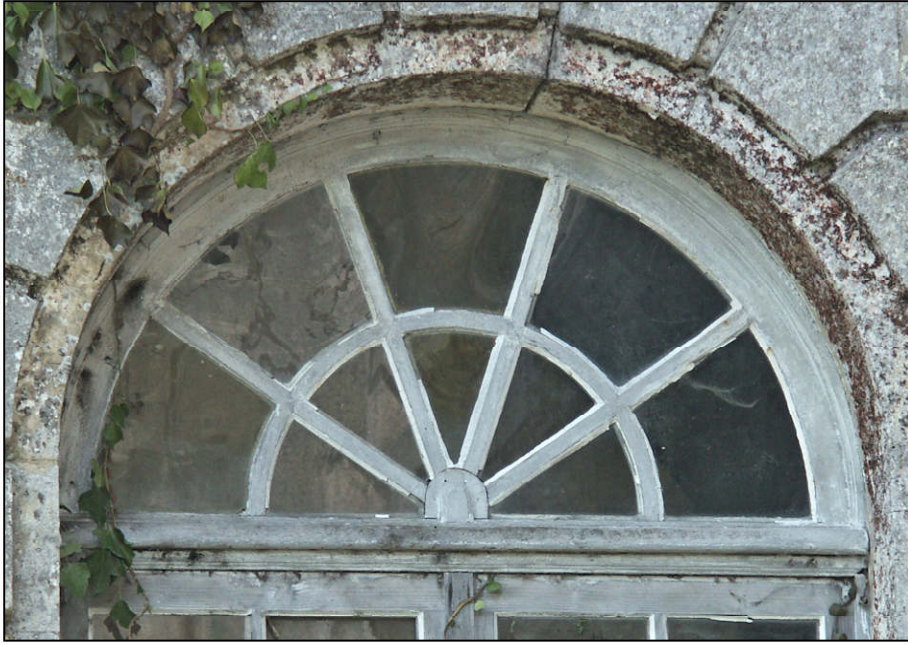
Fig. 12.1. Imposte en éventail (extérieur)
