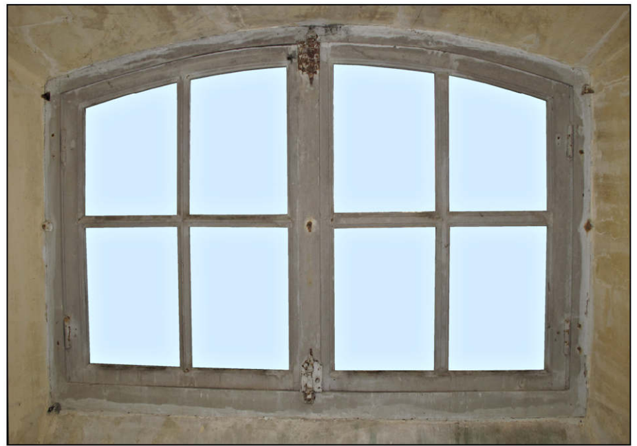
Fig. 12.4. Châssis du sous-sol (intérieur)
