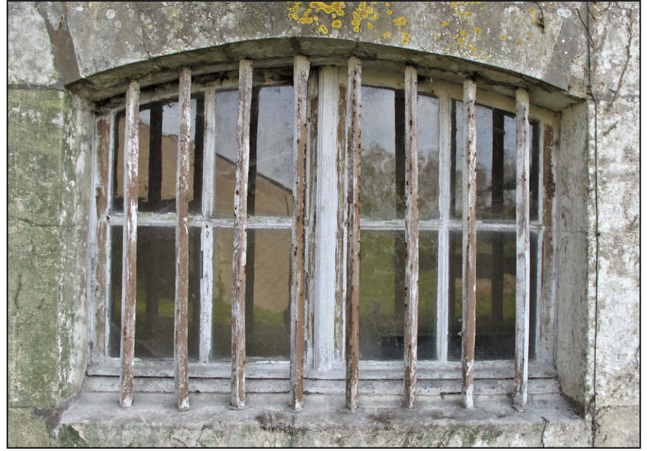
Fig. 12.2. Châssis du sous-sol (extérieur)
