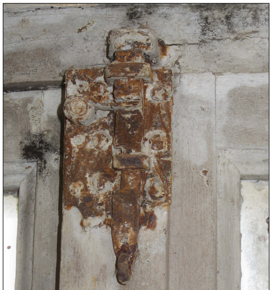
Fig. 12.6. Châssis du sous-sol / verrou supérieur
