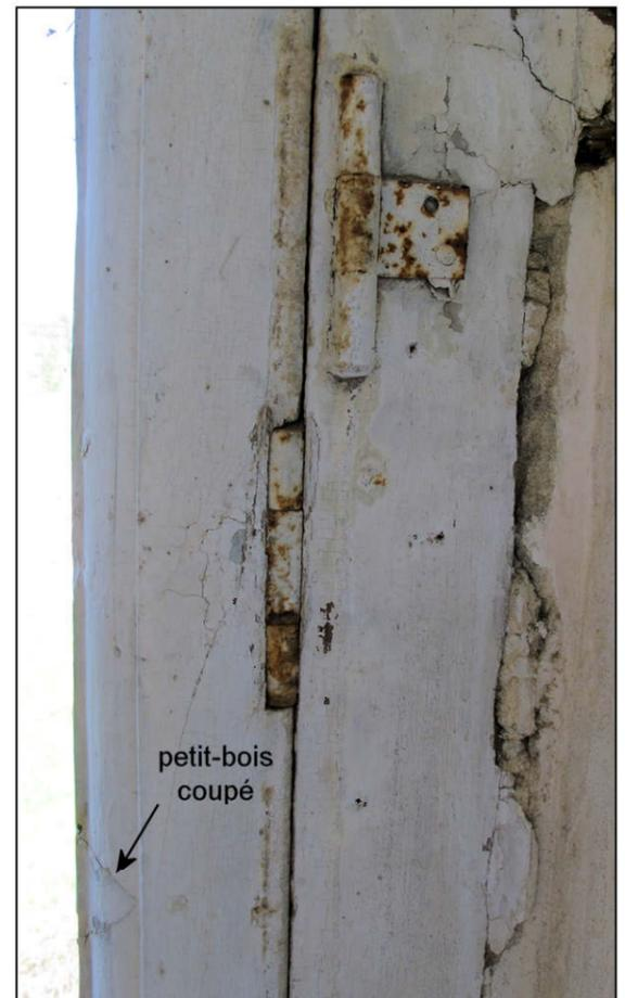
Fig. 6.5. Fiches (vantail vitré et volet)
