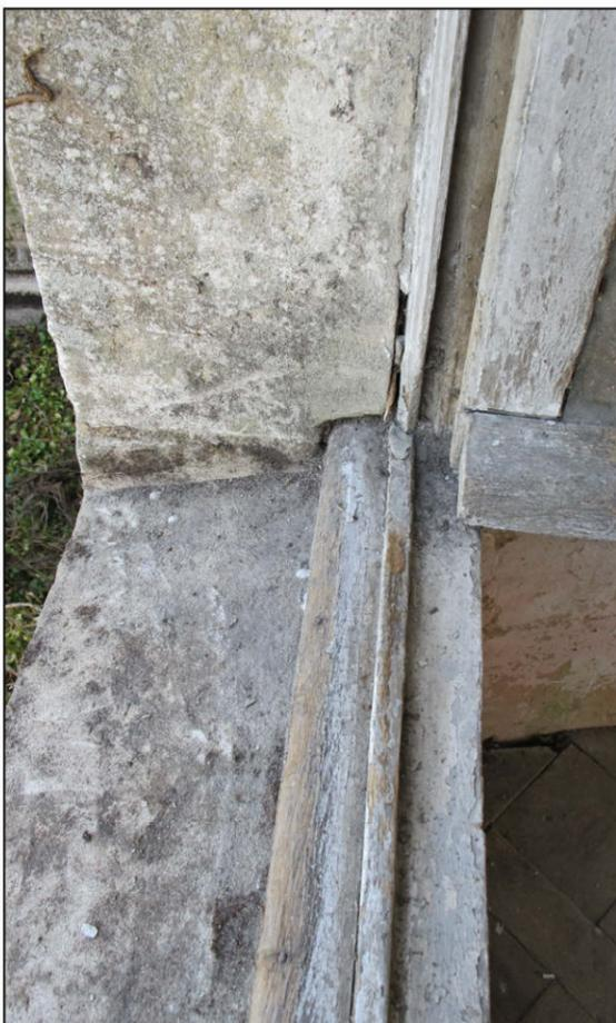
Fig. 6.3. Pièce d'appui
