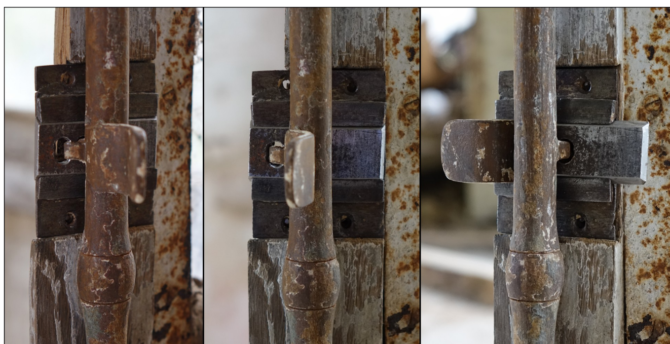
Fig. E.5. Restitution d'un verrou : espagnolette ouverte (clichés 1 et 2), espagnolette fermée (cliché 3).
