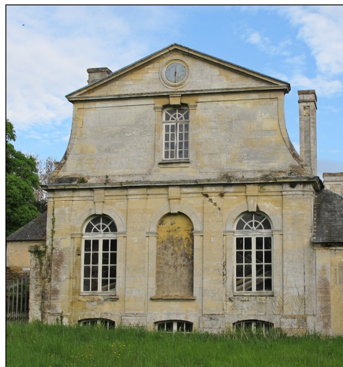
Fig. E.1. Les communs, bâtiment de l'Horloge
