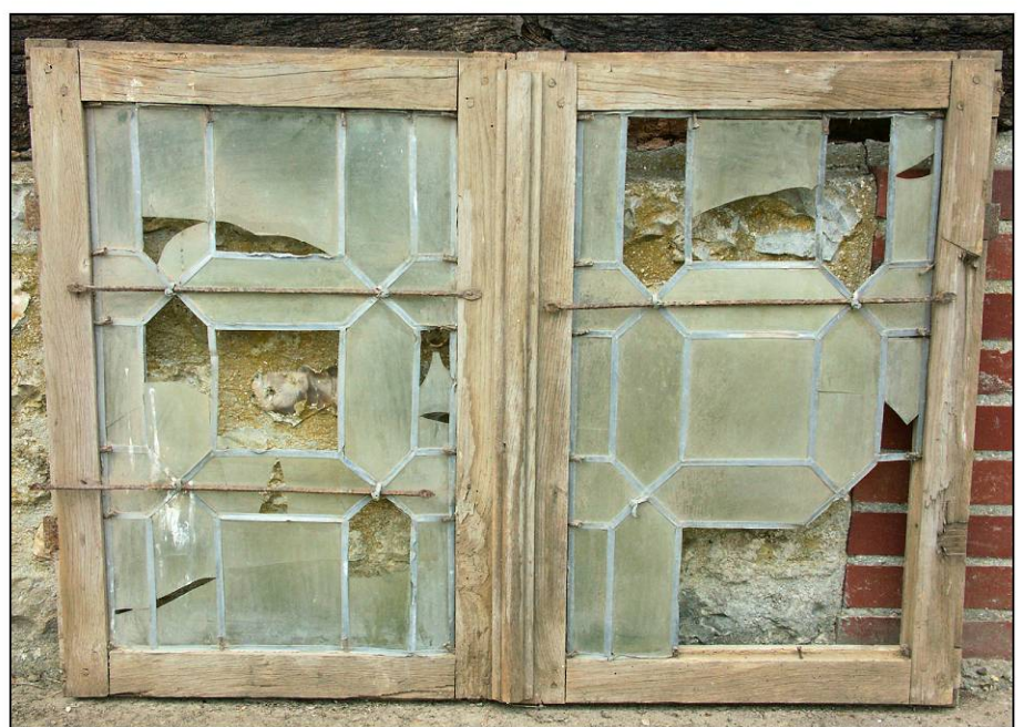
Fig. 1.6. 1er étage / imposte (extérieur)
