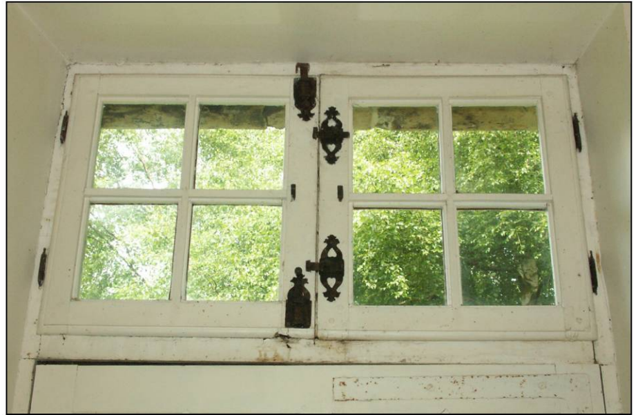
Fig. 1.2. Rez-de-chaussée / imposte (intérieur)
