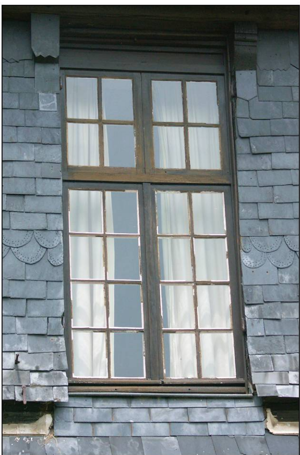
Fig. 1.5. Fenêtre du 1er étage
