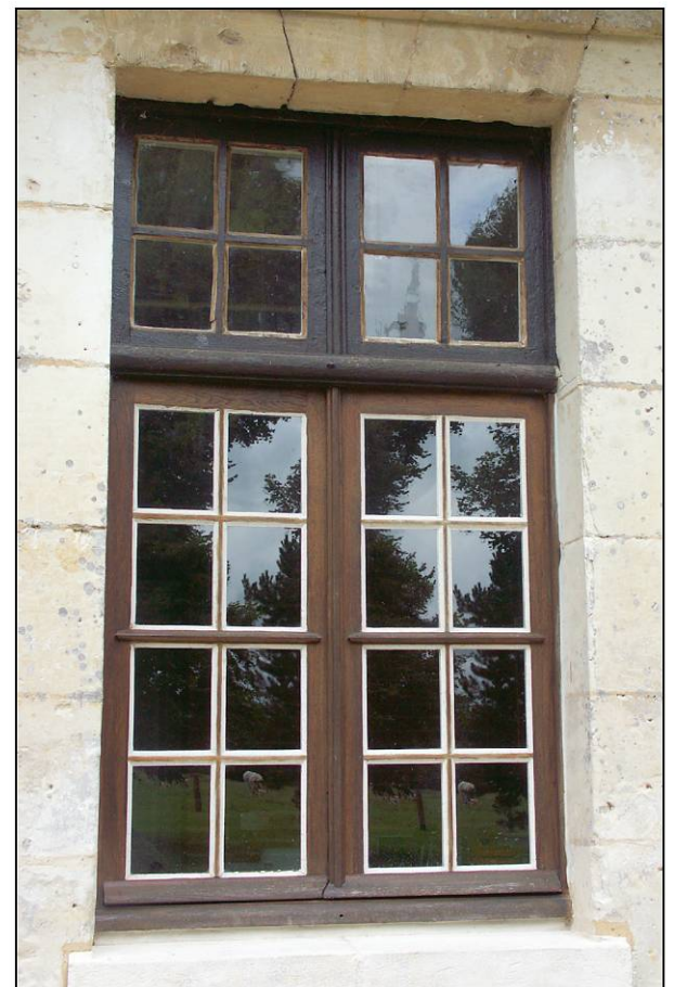
Fig. 1.4. Fenêtre du rez-de-chaussée
