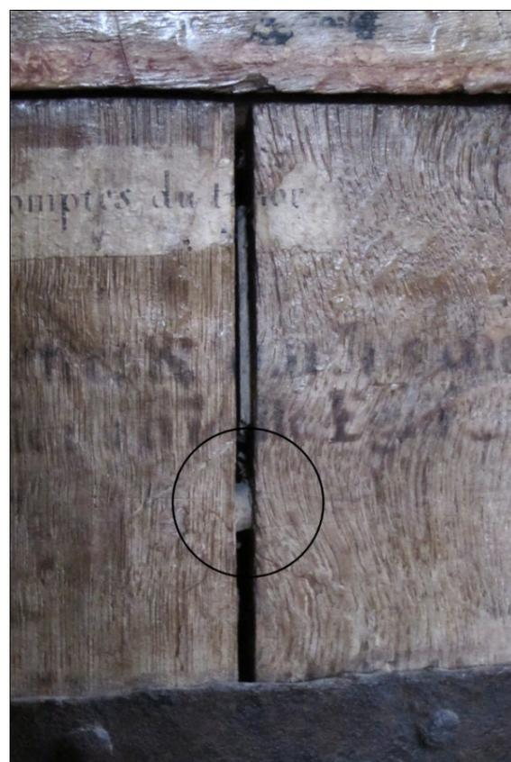
Fig. 7. Détail d'une porte de l'armoire de la cathédrale de Bayeux. Goujon horizontal pour maintenir les deux ais.
