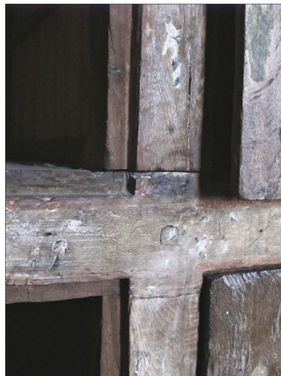
Fig. 6. Détail du bâti de l'armoire de la cathédrale de Bayeux. Assemblage de type A.
