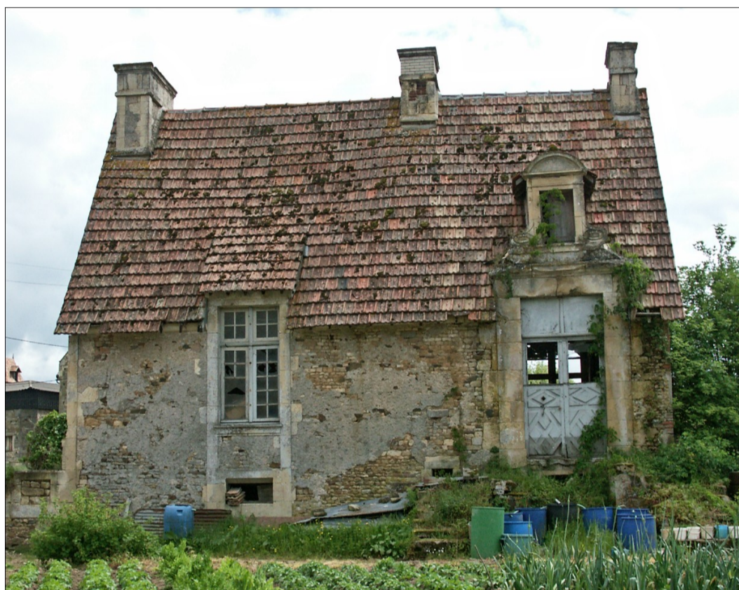
Fig. E.3. La façade nord en 2004
